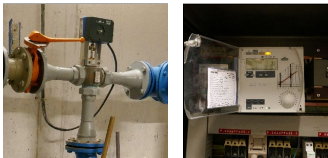
Vanne 3 voies et Régulateur
