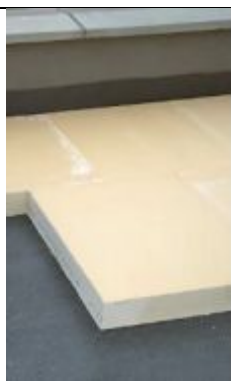
Isolation sous étanchéité
